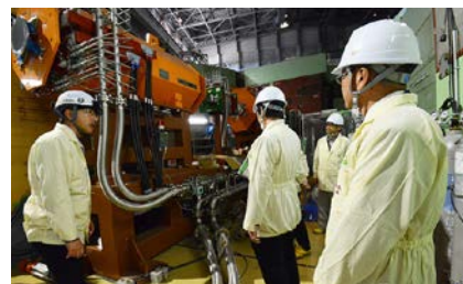
作業実施状況の現場視察(ハドロン実験施設)
