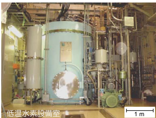
水素循環ユニット外観
