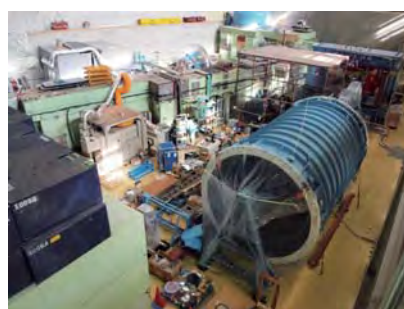
KOTO実験装置の組立て作業 (ハドロン実験施設/実験ホール南側)
