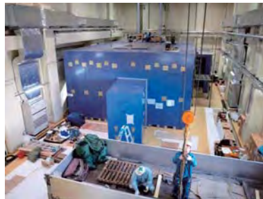
MLFで建設中の中性子BL09「SPICA」装置本体室の設置工事が行われた(東側増設建屋内)。
