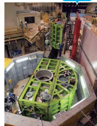
3分割で製作されたBLO2「DNA」の散乱真空槽が搬入・据付られた。
