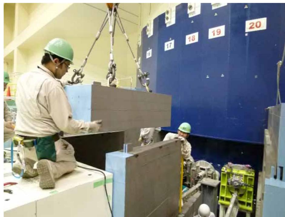
MLF実験ホールでは、ずれた遮蔽体を一時撤去し、点検後組み立て直す作業を実施中。内部の実験室は正常。
