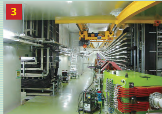
3-50BTビーム輸送路：写真向かって奥側やや上方の隔壁の向こうに位置するRCSからMRにビームを約220mにわたって輸送します。
