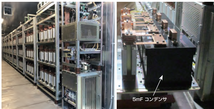
より速いサイクルで動く新電源システムのため新規開発された、(左)コンデンサバンクと(右)コンデンサユニットです。
