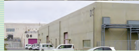
電源棟：電磁石電源や、加速空洞電源、制御機器等が置かれています。地下トンネルの加速器の各機器まで高電圧・大電流の電力を供給し、またビーム制御のための微弱なモニタ信号をトンネル内から受け取ります。当初D1～D3の3棟だけでしたが、増強計画のためD4～D6の3棟が新たに建設されました。
