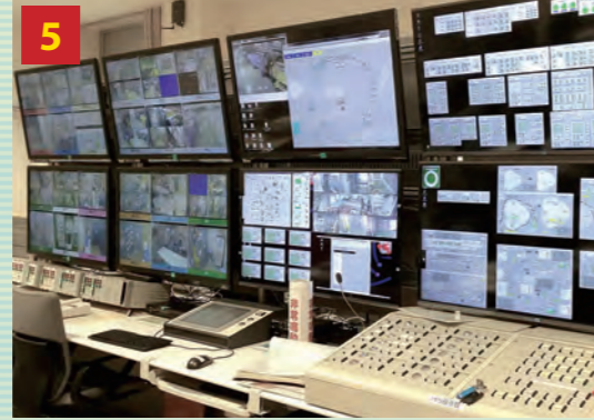
安全監視システム：加速器は放射線発生装置であるため入退域が厳密に管理、監視されています。
