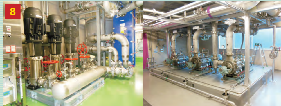
冷却水システム：電磁石や高周波加速空洞へ供給される電力は、最終的に熱となりそのままでは装置を高温にします。その熱の除去のため、純水を用いた冷却システムが3カ所の機械棟に整備されています。
