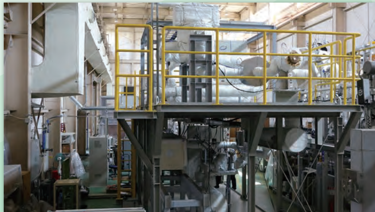
核変換実験施設用核破砕ターゲット模擬試験装置
